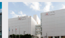
福岡PARCO 福岡県福岡市中央区天神2-11-1 本館:地下1階-地上8階 OPEN:2010.3.19 新館:地下2階-地上6階 OPEN:2014.11.13
