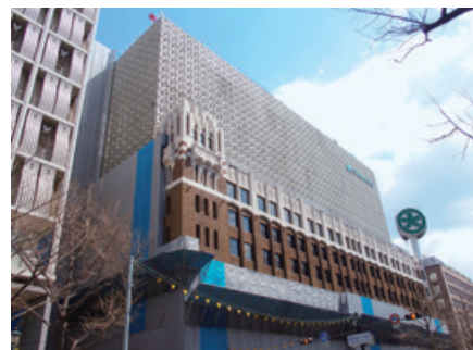
心斎橋店新本館工事中外観
