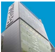
渋谷ZERO GATE 東京都渋谷区宇田川町15-1 地下1階-地上4階 OPEN : 2011 (H23).4.16
