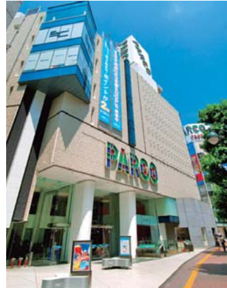
渋谷PARCO 東京都渋谷区宇田川町15-1 PART1: 地下1階-地上9階 OPEN : 1973 (S48).6.14 PART3: 地下1階-地上8階 OPEN : 1981 (S56).9.10 CLUB QUATTRO: 地上4階-5階 OPEN : 1988 (S63).6.28 ZERO GATE: 地下1階-地上4階 OPEN : 2002 (H14).4.27 2011 (H23) 4.16よりZERO GATE事業 として業態転換いたしました。 www.parco-shibuya.com
