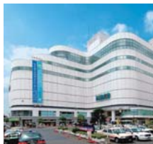
調布PARCO 東京都調布市小島町1-38-1 地下1階-地上10階 OPEN : 1989 (H1).5.25 www.parco-chofu.com
