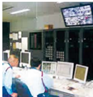
大丸東京店の防災センターでは、各種モニターで集中コントロールし全館の安全確認を行っています。
