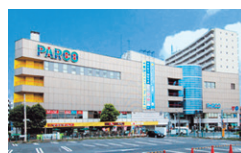
ひばりが丘PARCO 東京都西東京市ひばりが丘1-1-1 地下1階-地上5階 OPEN : 1993.10.8
