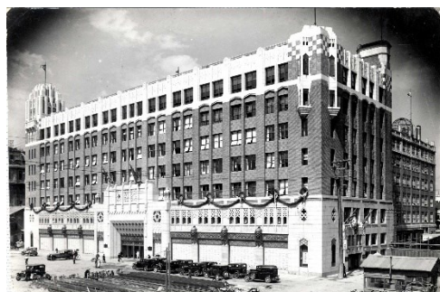
1933年「大丸心斎橋」 旧本館完成
