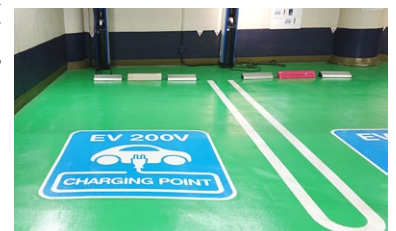
エンゼルパーク駐車場のEV充電スタンド
